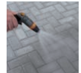
Fläche ausreichend wässern, Nachbehandlung beachten
