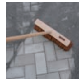
Sand einfügen und von der Oberfläche abfegen
